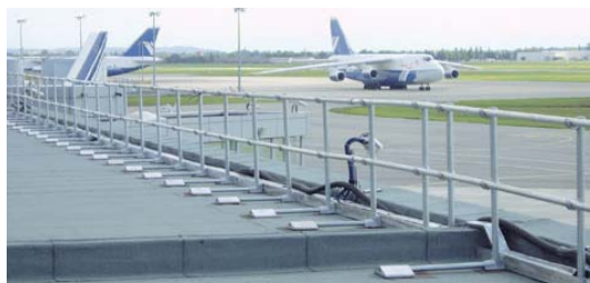
Protección de cubierta sin taladrar la lámina asfáltica mediante contrapesos.
